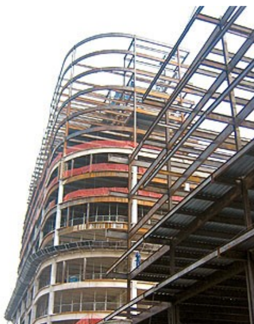
FIGURA 1- EDIFÍCIO WT NAÇÕES UNIDAS (SÃO PAULO), EXECUTADO COM ELEMENTOS MISTOS DE CONCRETO E AÇO. FONTE: REVISTA TÉCHNE (2008)
