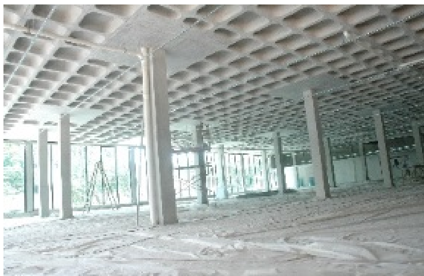
FIGURA 2 – LAJE-COGUMELO COM FASES MACIÇAS NAS REGIÕES DE APOIO
