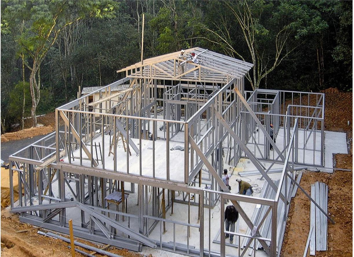
*Figura 2 - Exemplo de uma casa em construção no Sistema Light Steel Framing (Fonte: REFORMOLAR).*
