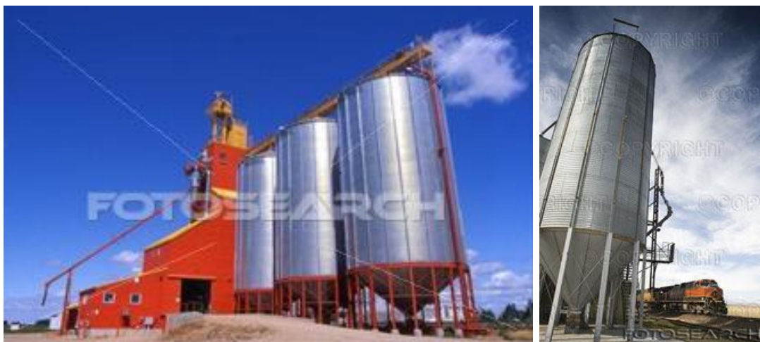
Figura 1 – Reservatório de fundo plano e cônico.
