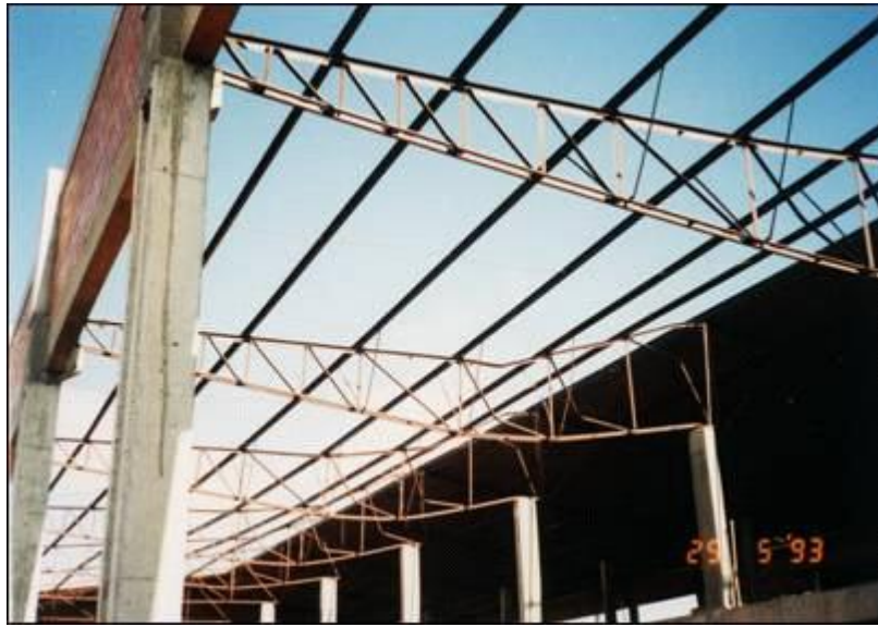
Foto 1 – Cobertura – Geometria da treliça a ser analisada.
