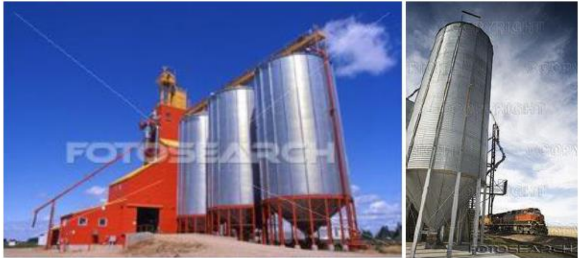
Figura 1. Reservatório de Fundo Plano e Cônico
