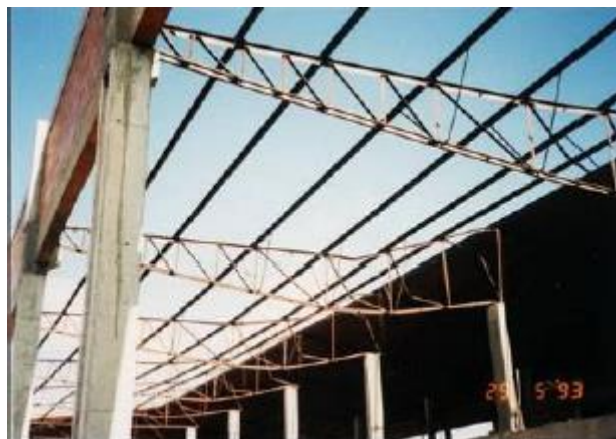
Figura 1. Cobertura - Geometria da treliça a ser analisada.
